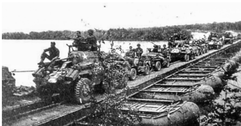
Le 25 août, les troupes américaines franchissent la Seine en utilisant un pont composé de bateaux gonflables reliés entre eux par des poutrelles métalliques.
